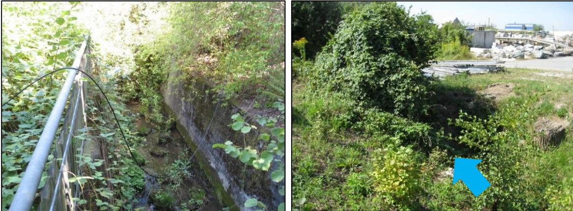
**Abbildung 11: Abschnitte des Mühlbaches, die renaturiert werden sollen. Links (1): Abschnitt nordöstlich des Gebäudes mit beidseitiger Beton-Ufermauer, die entfernt werden soll (Aufnahme von Süden); rechts (2): Verdolter Abschnitt, der geöffnet werden soll (Aufnahme von Norden).**
