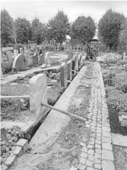
Die Grabsteine werden während der Bauarbeiten abgestützt und deren Fundament bei Bedarf mit verdichtetem Kies zur Standsicherheit neu unterfüttert.
